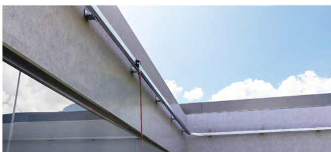
ГОРИЗОНТАЛЬНАЯ РЕЛЬСОВАЯ АНКЕРНАЯ ЛИНИЯ
