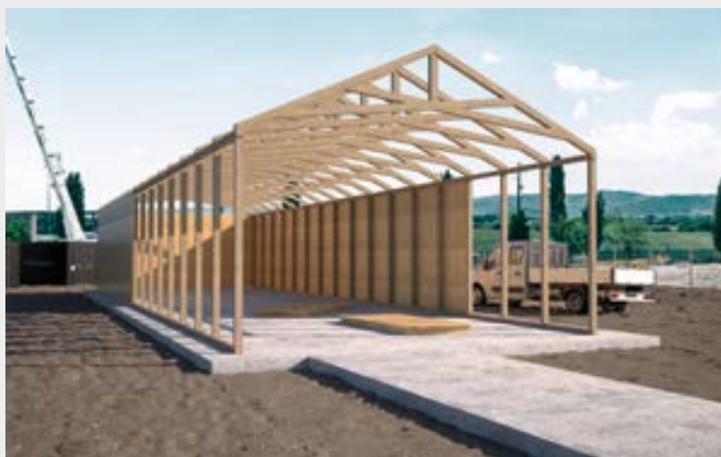
^ Pritrjevanje ogrodja Wood Trusses na prostem.
