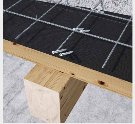
30° 커넥터가 이중 열로 배열되어 있는 합성 목재-콘크리트 바닥.
