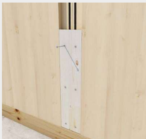
Upevnění stěn z CLT vruty HBS o průměru 6 mm.
